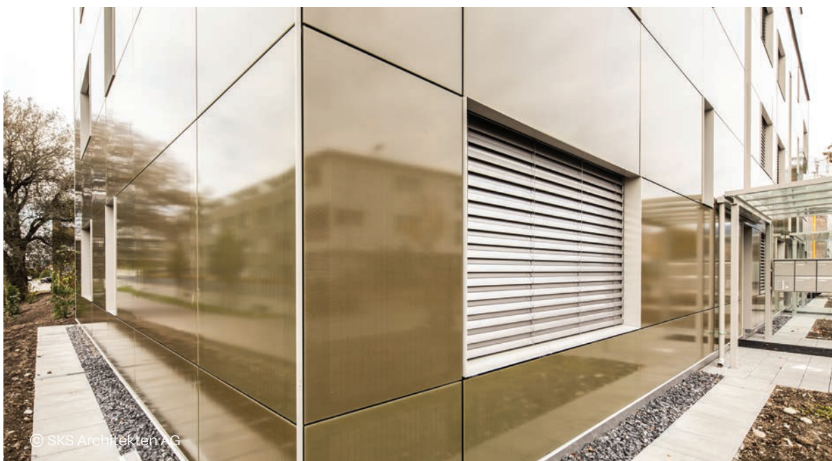
Solar façade in Muensingen (Berne)
