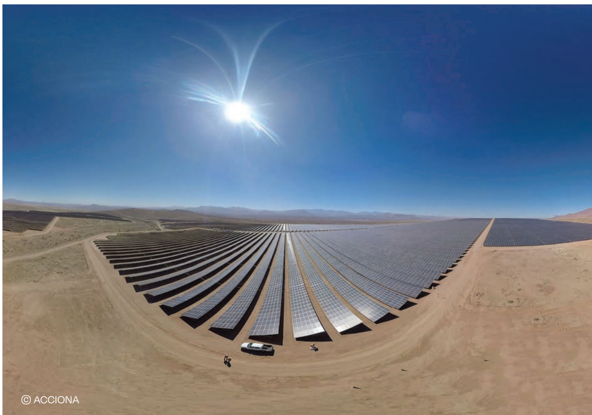
246 MW El Romero Solar PV plant, Atacama Desert, Chile
